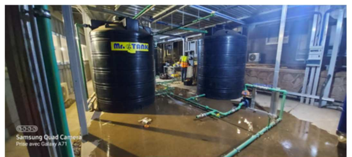
Photo 05. Installation d'une unité de potabilisation
