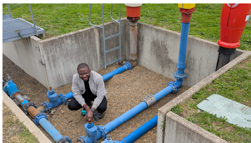
Photo 53. Ateliers de formation des travaux hydrauliques/ oieau-France
