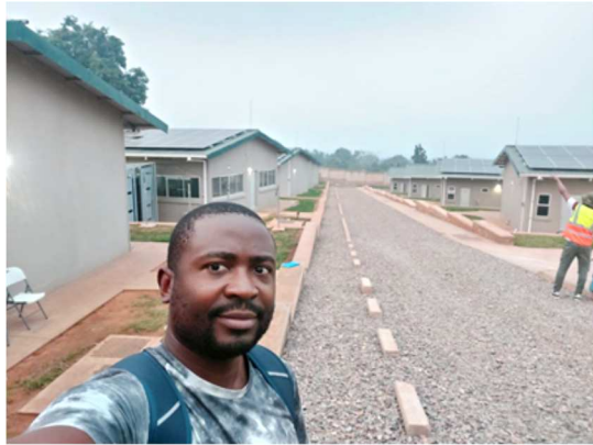
Photo 02. Desserte en eau potable d'un camp de 44 équivalent-habitants
