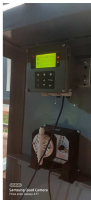
Photo 14. Installation d'une pompe doseuse/chloration
