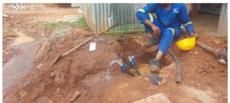
Photo 07. Purge d'un réseau de distribution
