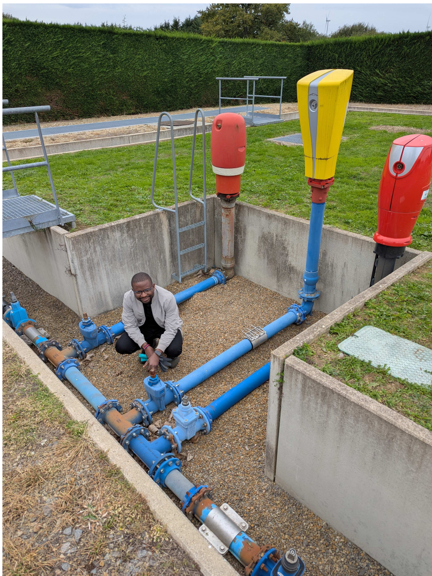
Photo 52. Ateliers de formation des travaux hydrauliques/ oieau-France
