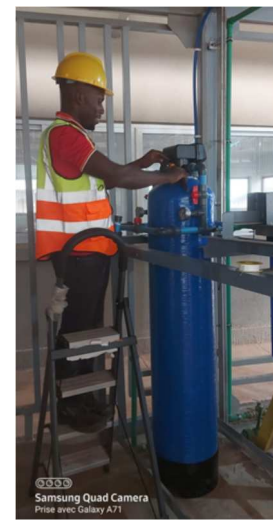
Photo 09. Installation d'un filtre à sable
