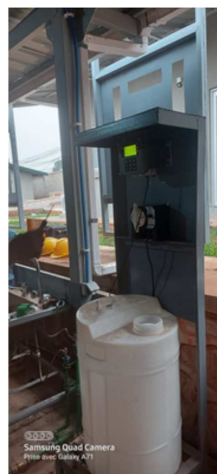
Photo 15. Installation d'une pompe doseuse/chloration
