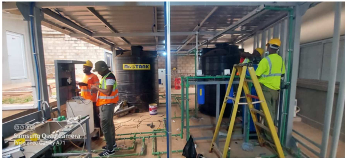
Photo 08. Installation d'une unité de potabilisation
