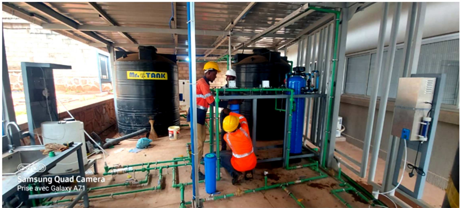
Photo 01. Installation d'une unité de potabilisation
