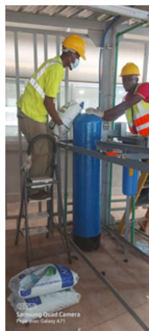
Photo 16. remplissage d'un filtre à sable
