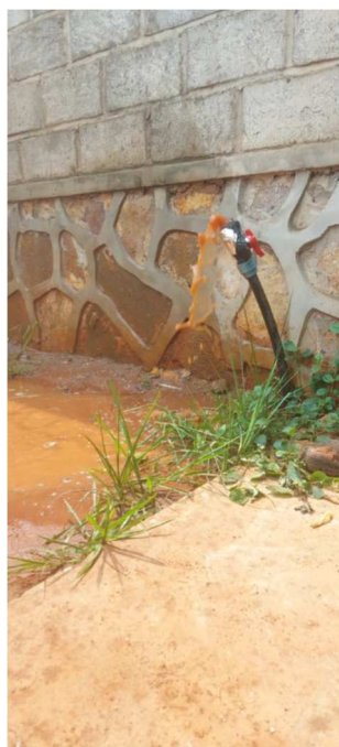
Photo 10. potabilisation de l'eau
