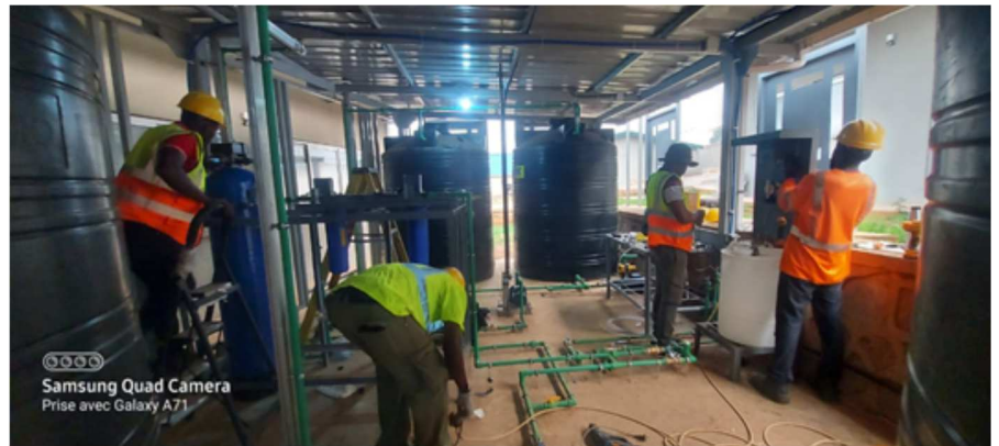
Photo 03. Installation d'une unité de potabilisation
