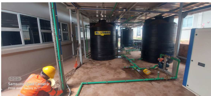
Photo 06. Installation d'une unité de potabilisation
